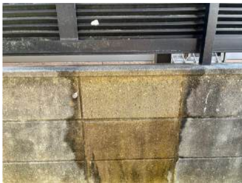
施工後 5分経過
